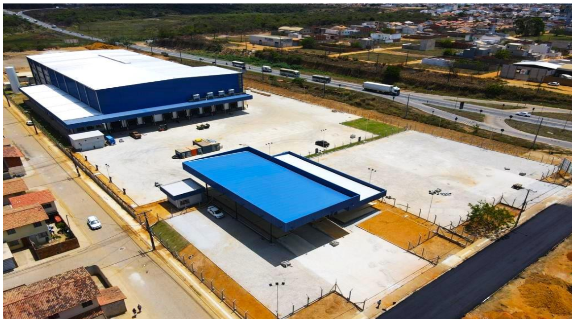
Execução de obra Seara VDC/BA – Foto Panorâmica
