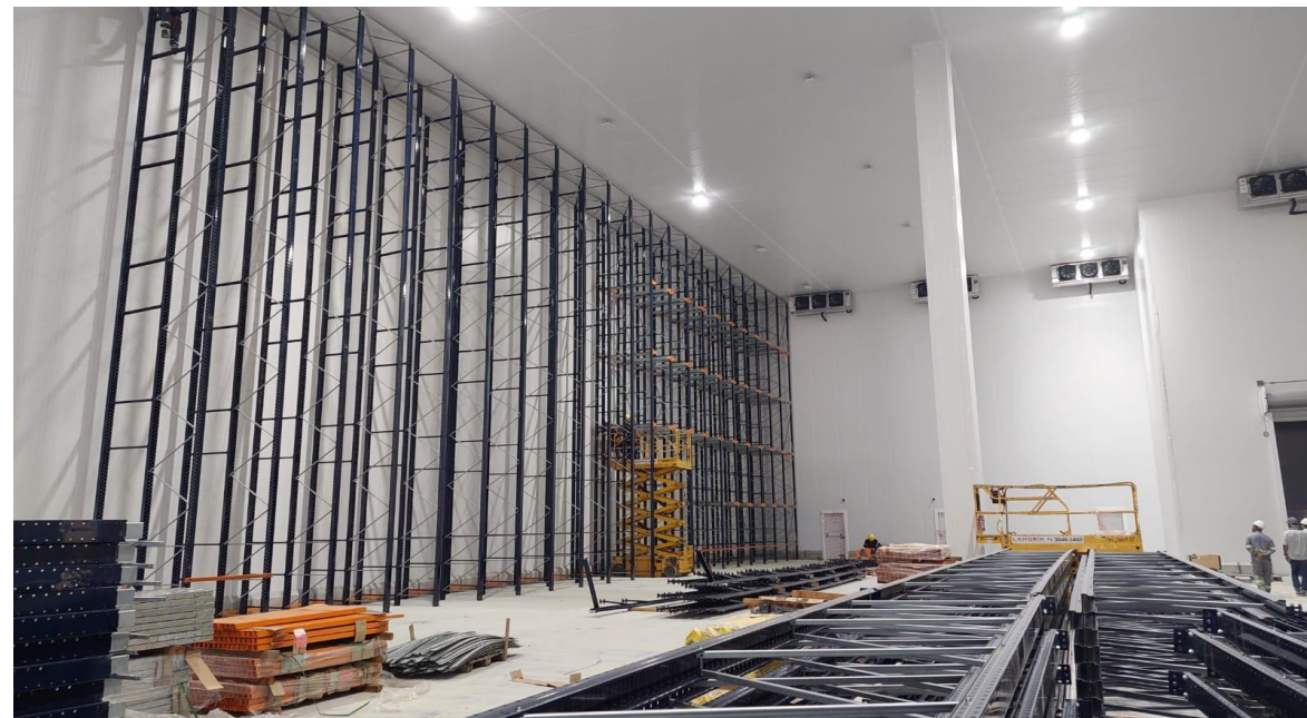
Execução de obra Seara VDC/BA
