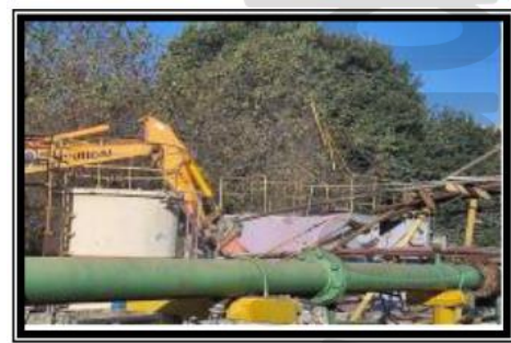
Remoção de tanque - antiga ETE
