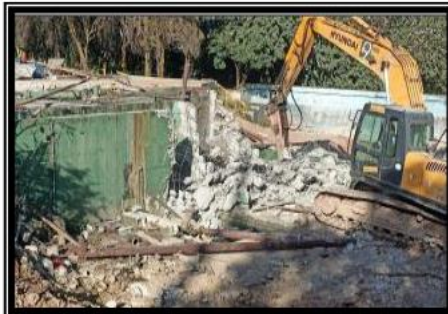
Demolição tanque - antiga ETE
