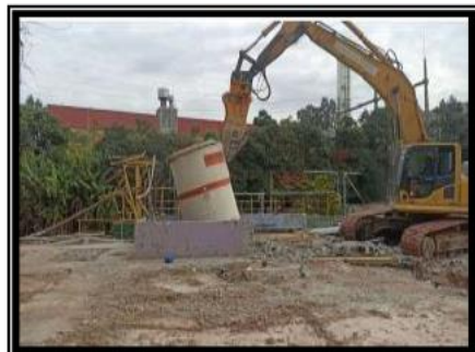
Remoção de tanque
