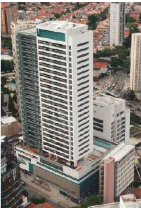
Foto Fachada da Obra - Misce
