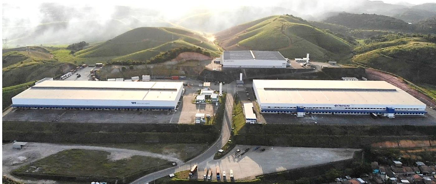
Imagem 1: Foto Aérea do Imóvel
