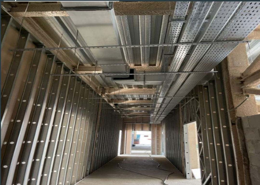
Drywall e estrutura elétrica
