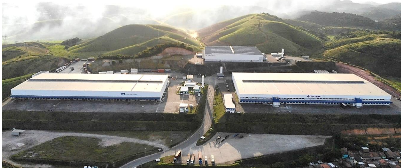
Imagem 1: Foto Aérea do Imóvel
