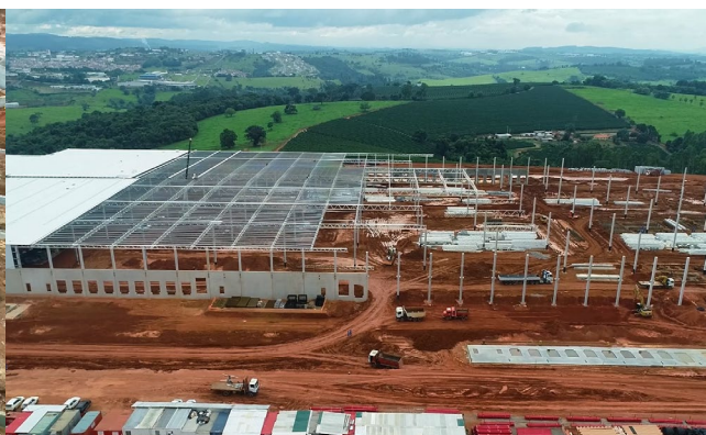
Visão geral do galpão
