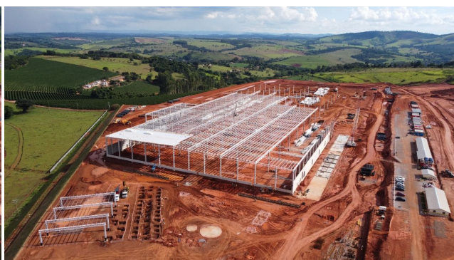
Visão geral do galpão (novembro).
