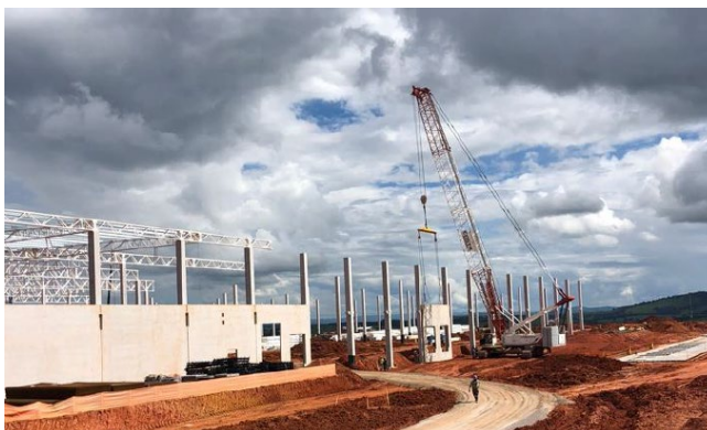
Montagem de painéis Tilt-up.
