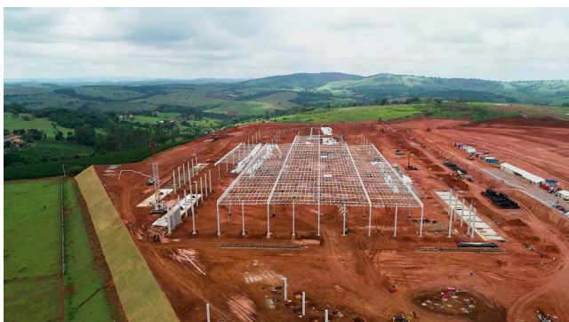
Visão geral do galpão (outubro).
