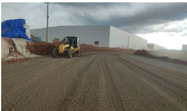
Preparo de base de pavimento intertravado.
