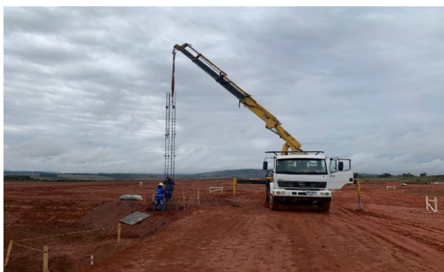
Fundação: execução de estacas.
