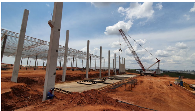
Montagem e fabricação de painel Tilt-up de fachada.
