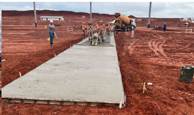
Execução de pista de fabricação de pilares
