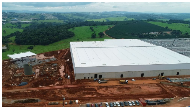
Visão geral do galpão.
