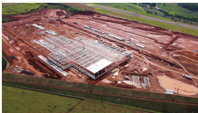
Visão geral do galpão (novembro).
