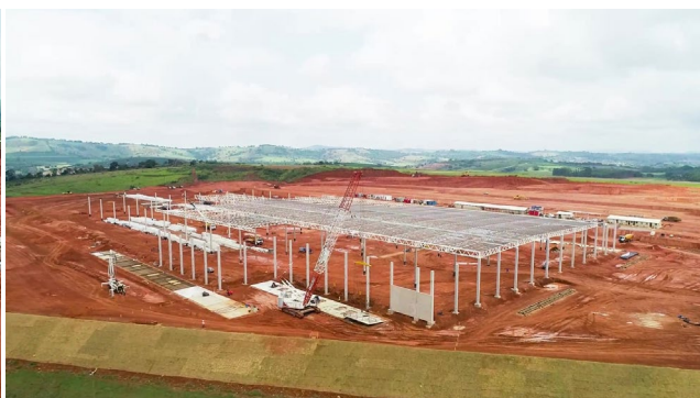
Visão geral do galpão (outubro).
