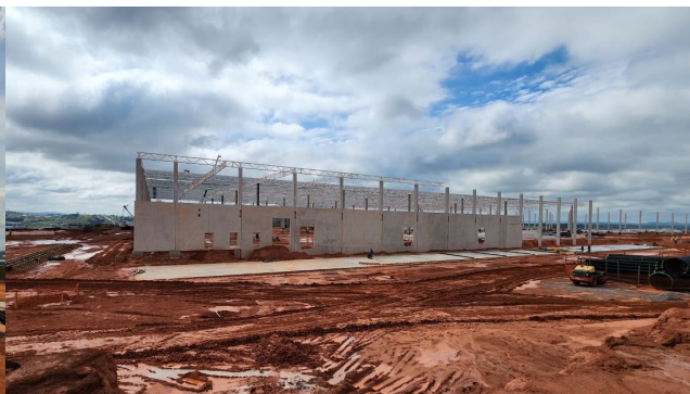
Painéis Tilt-up de fachada.
