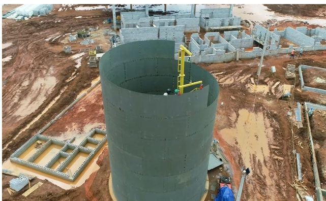
Montagem de reservatório de incêndio.
