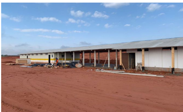
Montagem de canteiro de obras.
