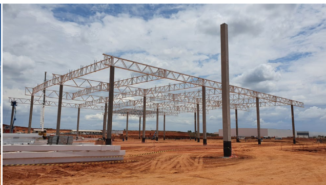
Estrutura de cobertura do galpão.
