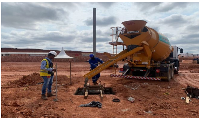
Fundação: execução de blocos
