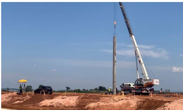
Montagem de pilares pré-moldados.
