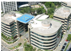
Edifício Millennium Office Park ABL: 4.410 m 2
