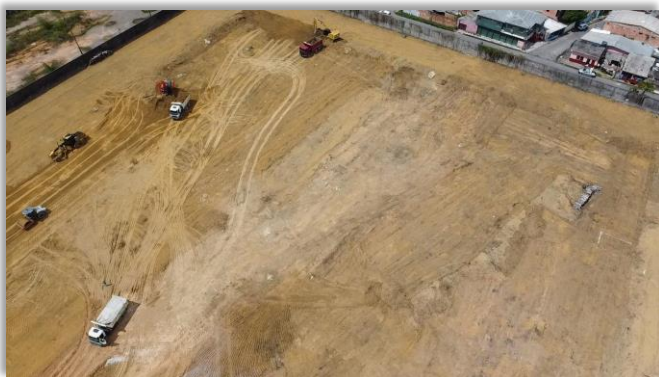
Vista aérea da obra.
