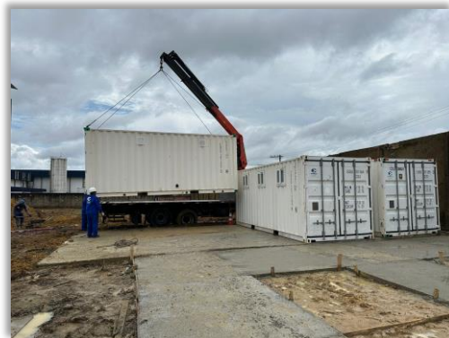
Instalações dos containers de vestiários e banheiros.
