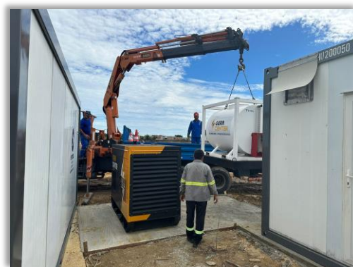
Instalação do gerador
