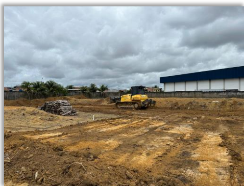
Atividades de terraplenagem e limpeza do terreno.
