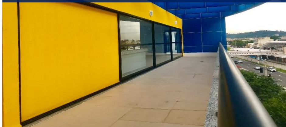
Fachada Principal - Depois
