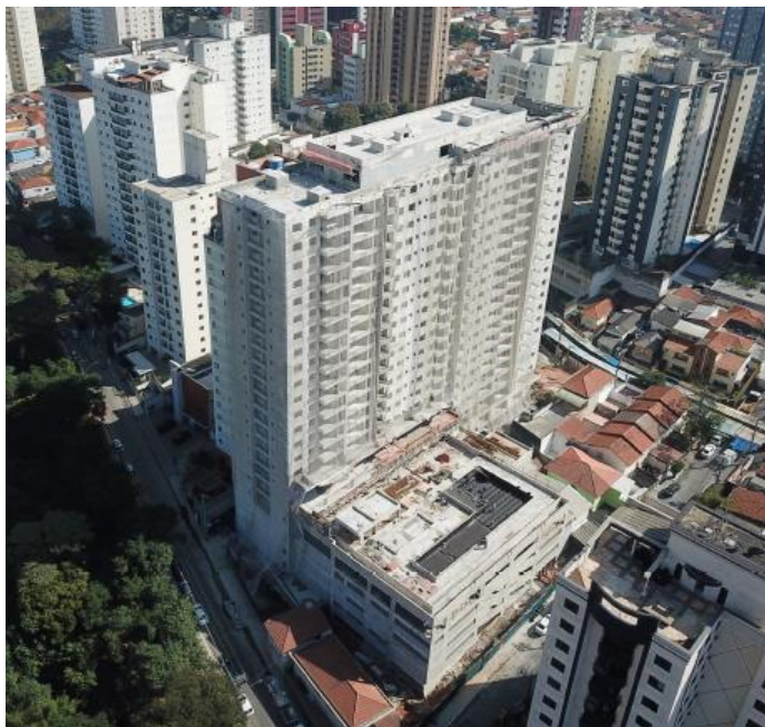
Foto Vista Geral Obra
