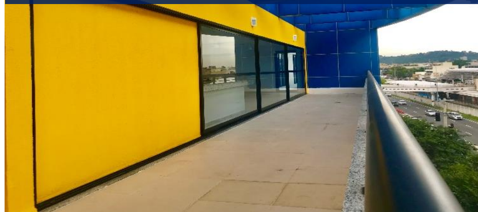
Fachada Principal - Depois
