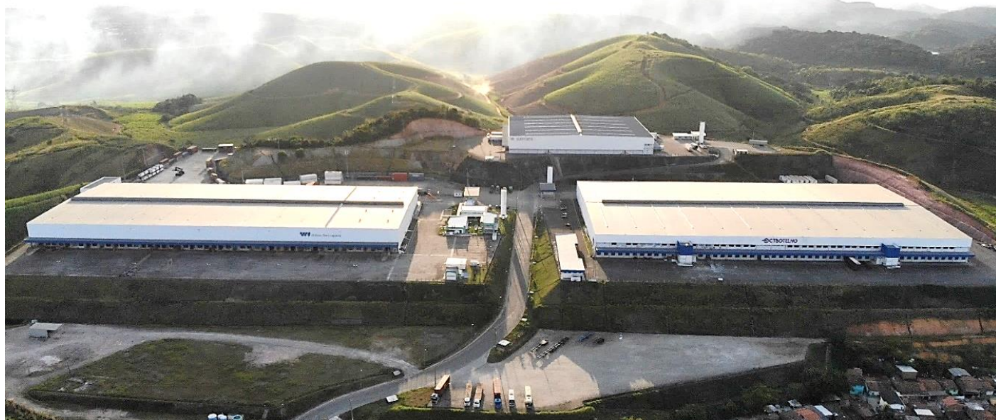
Imagem 1: Foto Aérea do Imóvel
