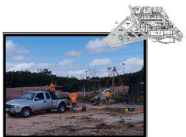
Sondagem - etapa II
