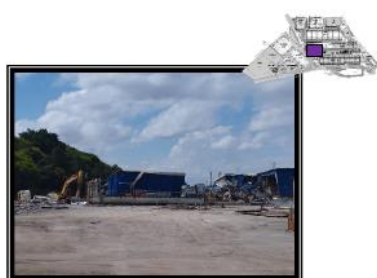
Remoção de estrutura metálica - antigo prédio 70
