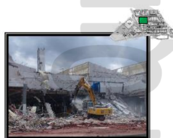
Demolição do mezanino - antigo prédio 33
