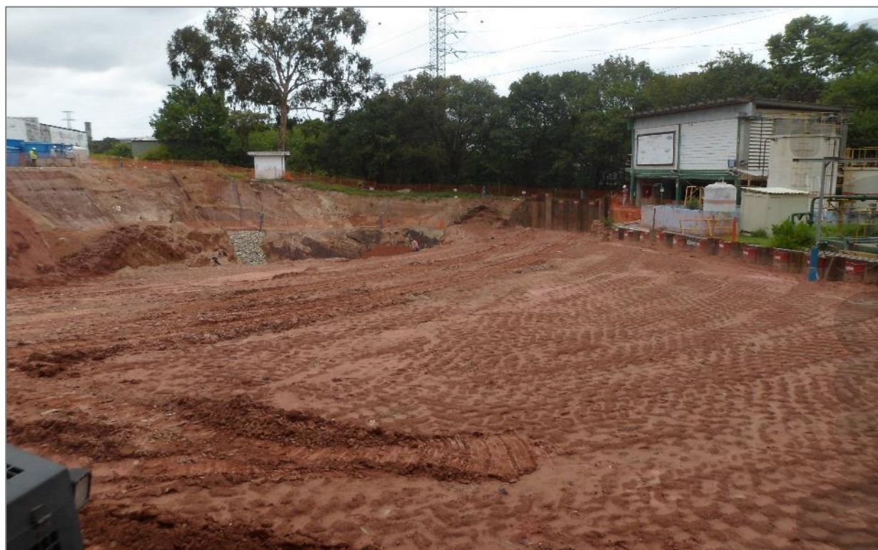
Vista do local em escavação, 07/11/2022
