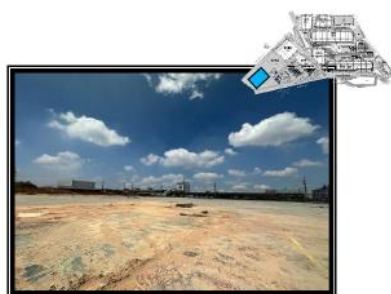
Vista geral - antigo prédio 93
