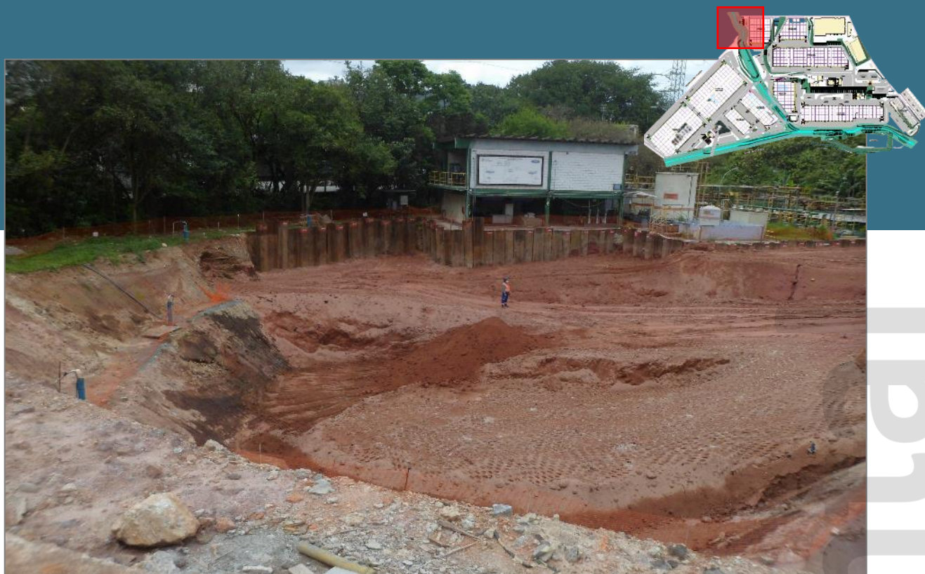
Vista do local em escavação, 07/11/2022
