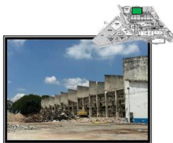
Demolição de alvenaria/ concreto - antigo prédio 36
