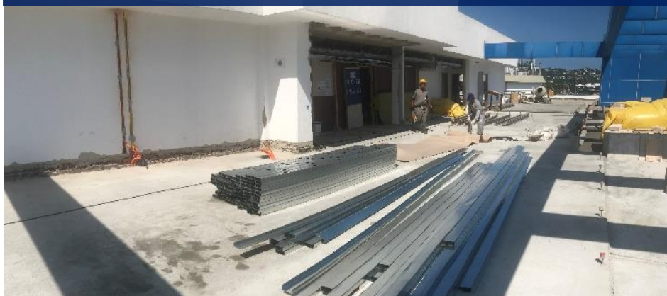
Fachada Principal - Antes
