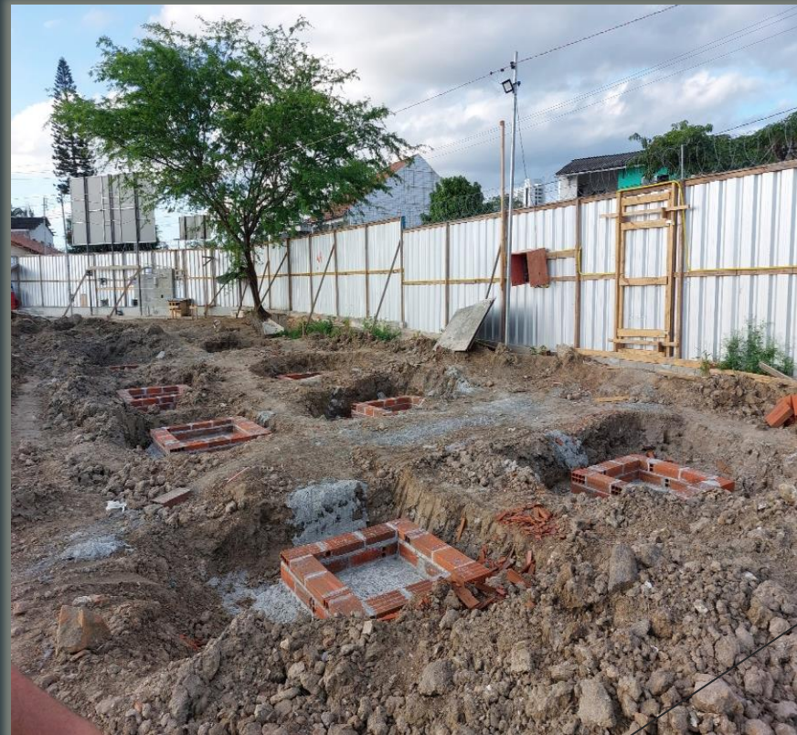
Concretagem das bases das sapatas do pórtico da entrada
