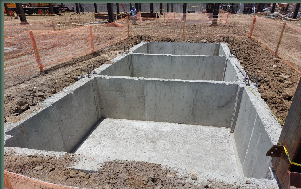
Fosso dos elevadores
