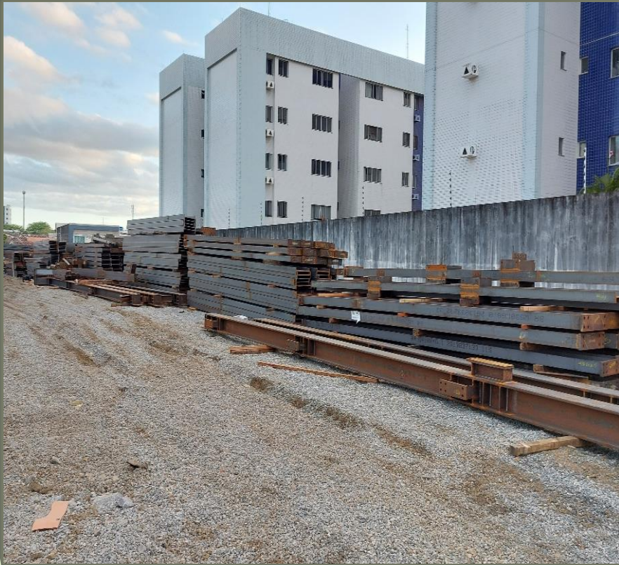
Armazenagem das estruturas metálicas na obra
