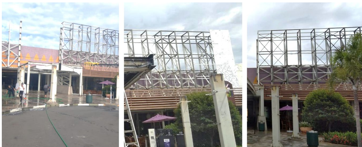
Em execução: Fachada
