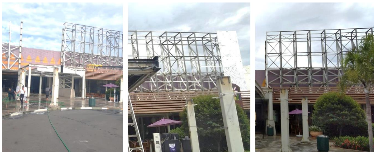
Em execução: Fachada
