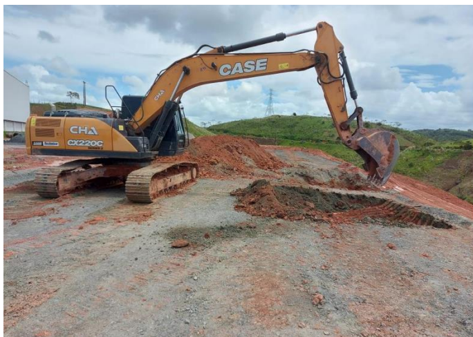
Imagem 6: Reparos no Talude
