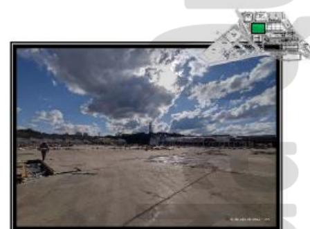
Demolição - antigo prédio 34/35
