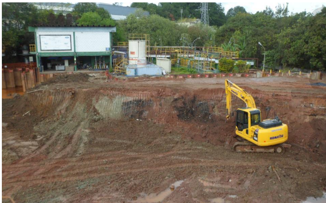
Vista do local em escavação, 11/08/2022
