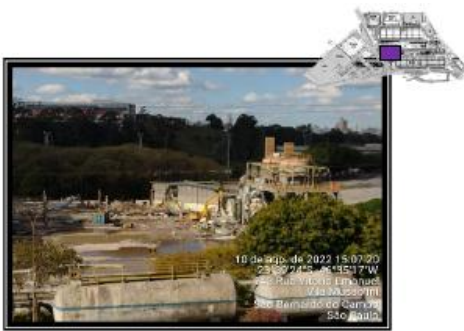
Demolição metálica - antigo prédio 70
