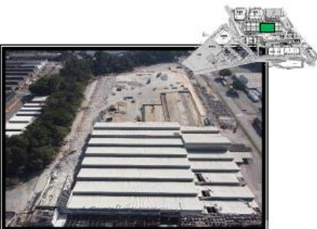
Remoção de telhas de cobertura - antigo prédio 33
