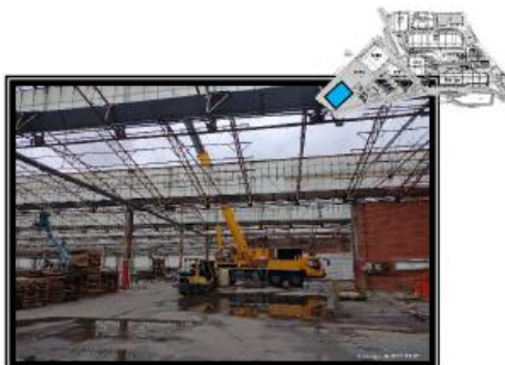
Demolição metálica - antigo prédio 93
