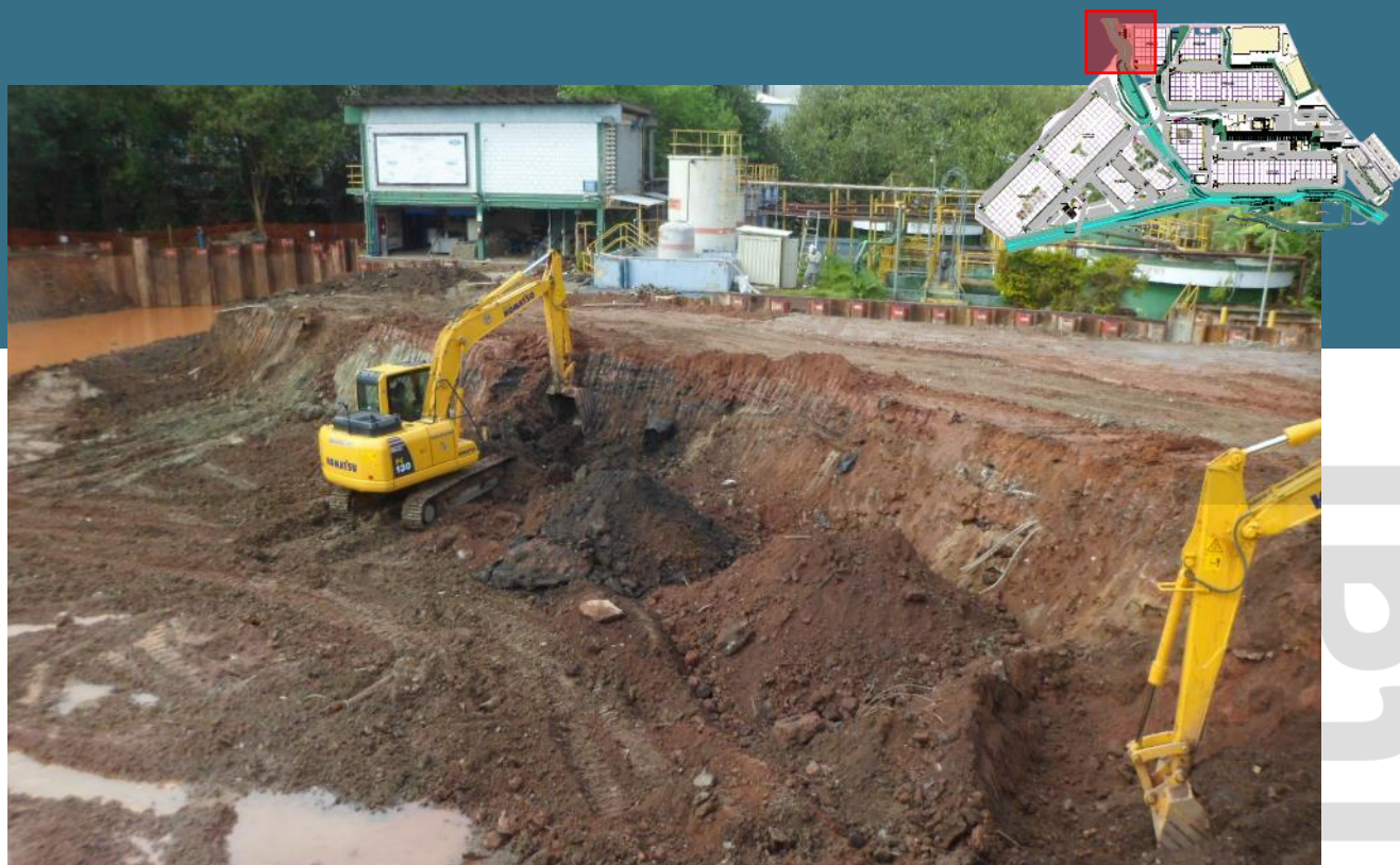
Vista do local em escavação, 11/08/2022
