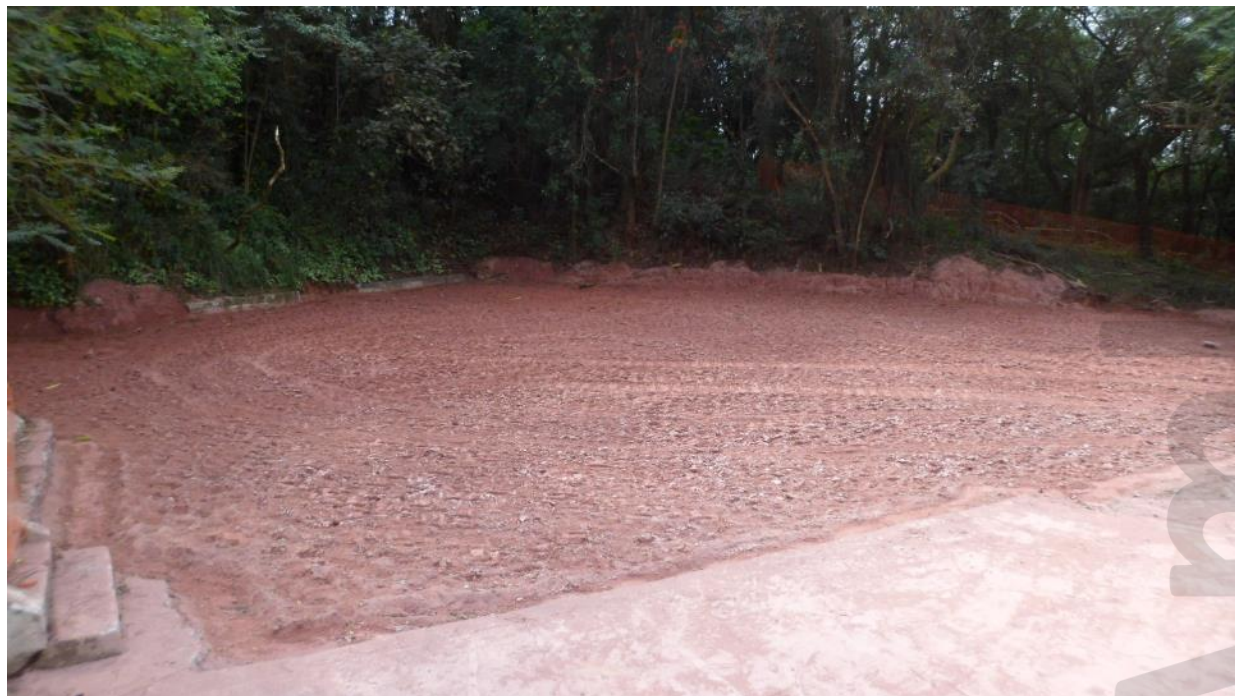
Detalhe: Reaterro concluído, 18/07/2022
