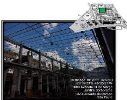
Remoção de telhas de cobertura - antigo prédio 36
