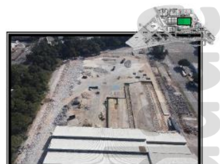
Demolição - antigo prédio 32
