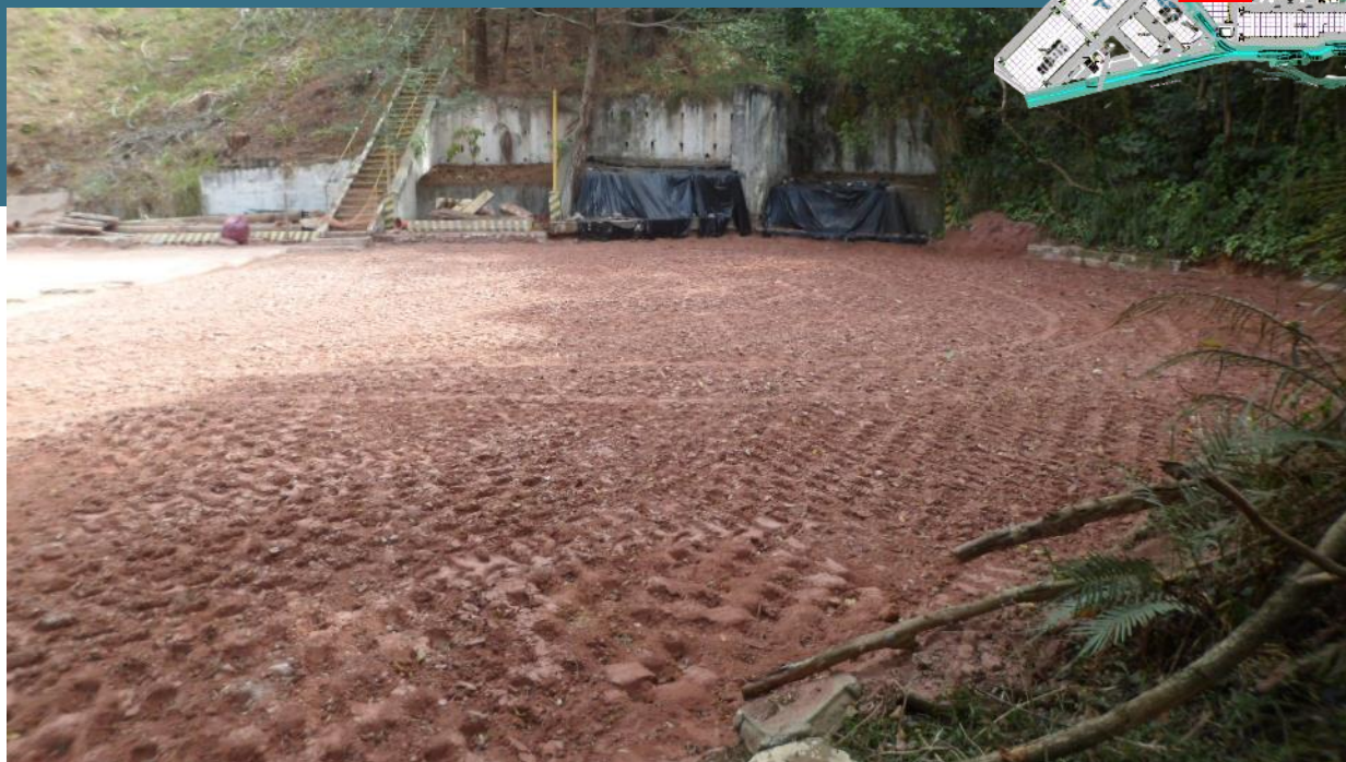
Detalhe: Reaterro concluído, 18/07/2022
