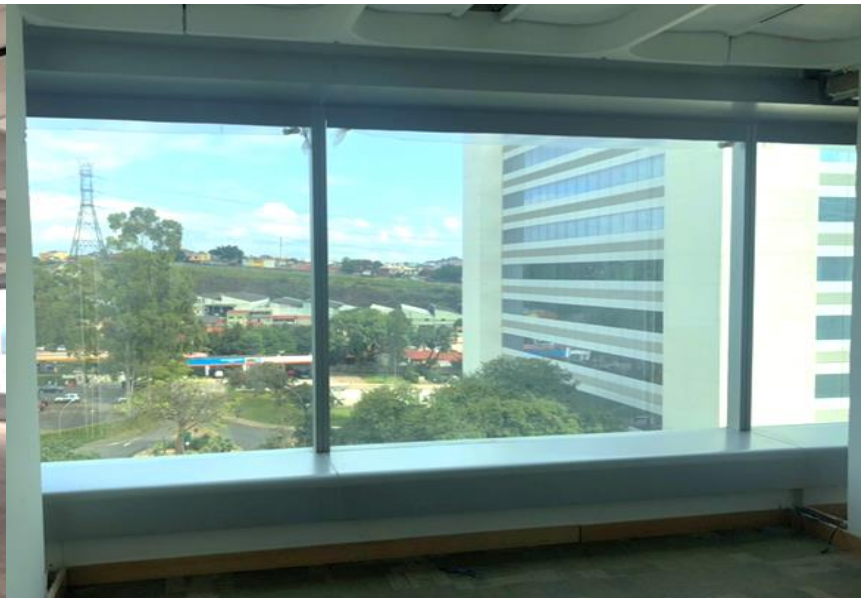
Vista Externa – Andar Tipo
