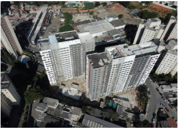
Foto Estrutura Obra
