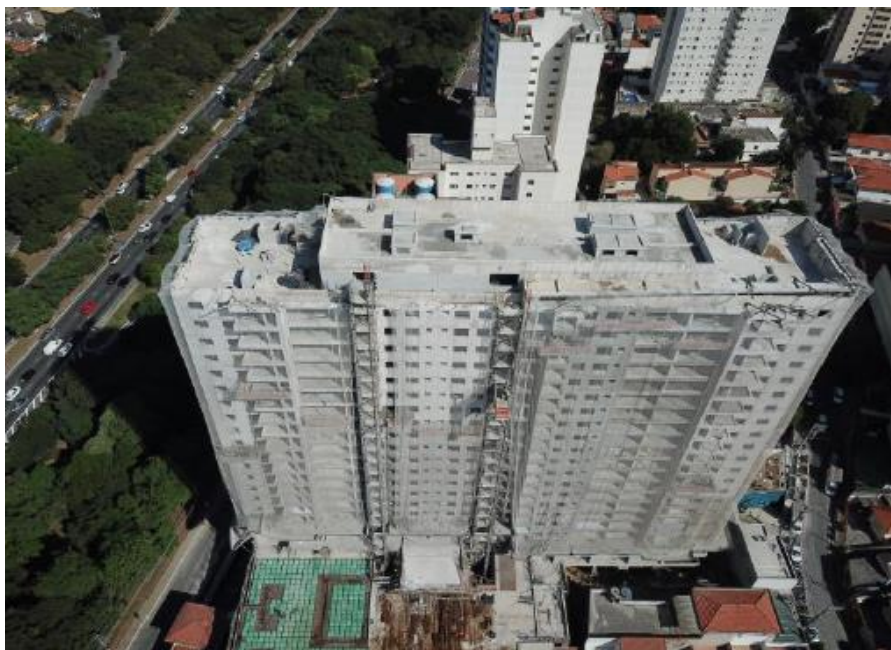
Foto Vista Geral Obra
