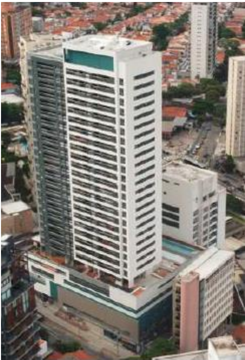
Foto Fachada da Obra - Misce
