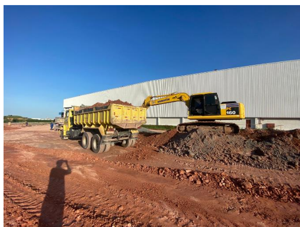
Imagem 6: Reparos no Talude
