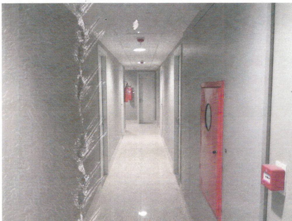
Corredor 3º Pavimento Bloco 4
