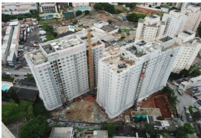
Foto Estrutura Obra
