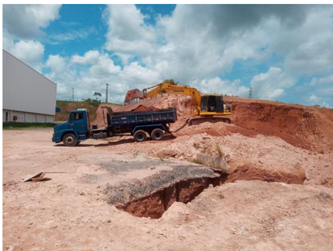
Imagem 9: Reparos no Talude
