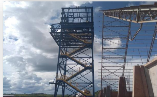
Transportadores – Montagem das estruturas
