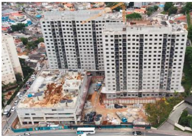
Foto Estrutura Obra
