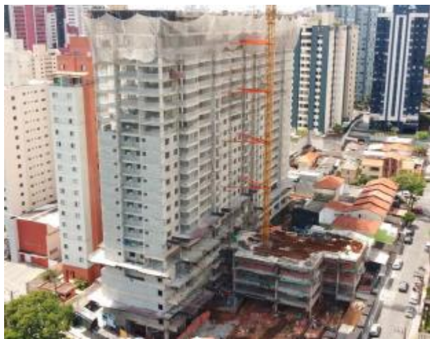
Foto Vista Geral Obra
