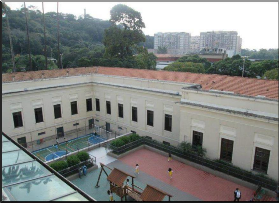
Vista do Pátio Interno
