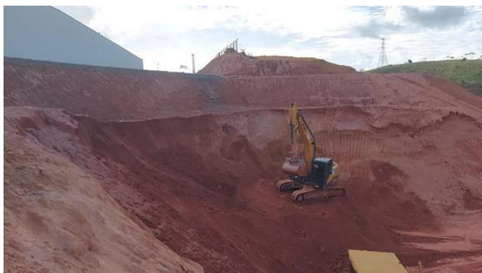
Imagem 9: Reparos no Talude
