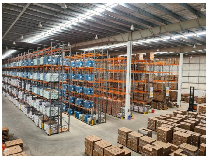
Imagem 6: Foto Interna dos Galpões
