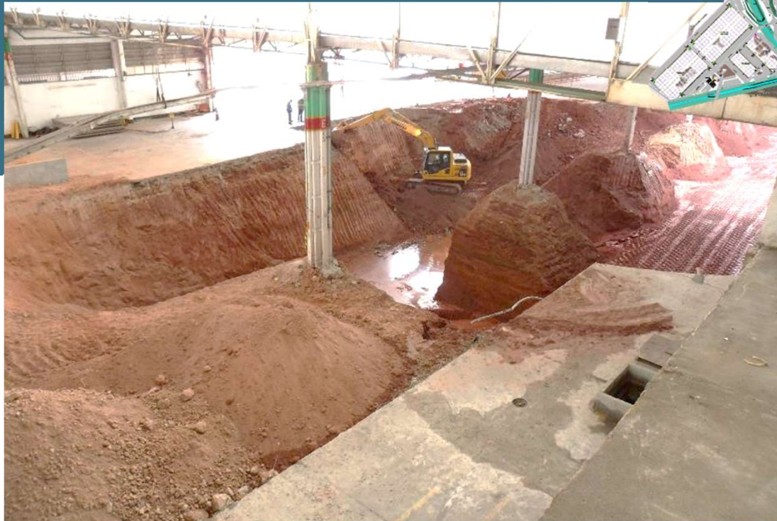
Atual Prédio 33, futuro prédio 700, Escavação em Curso– 19/10/2021
