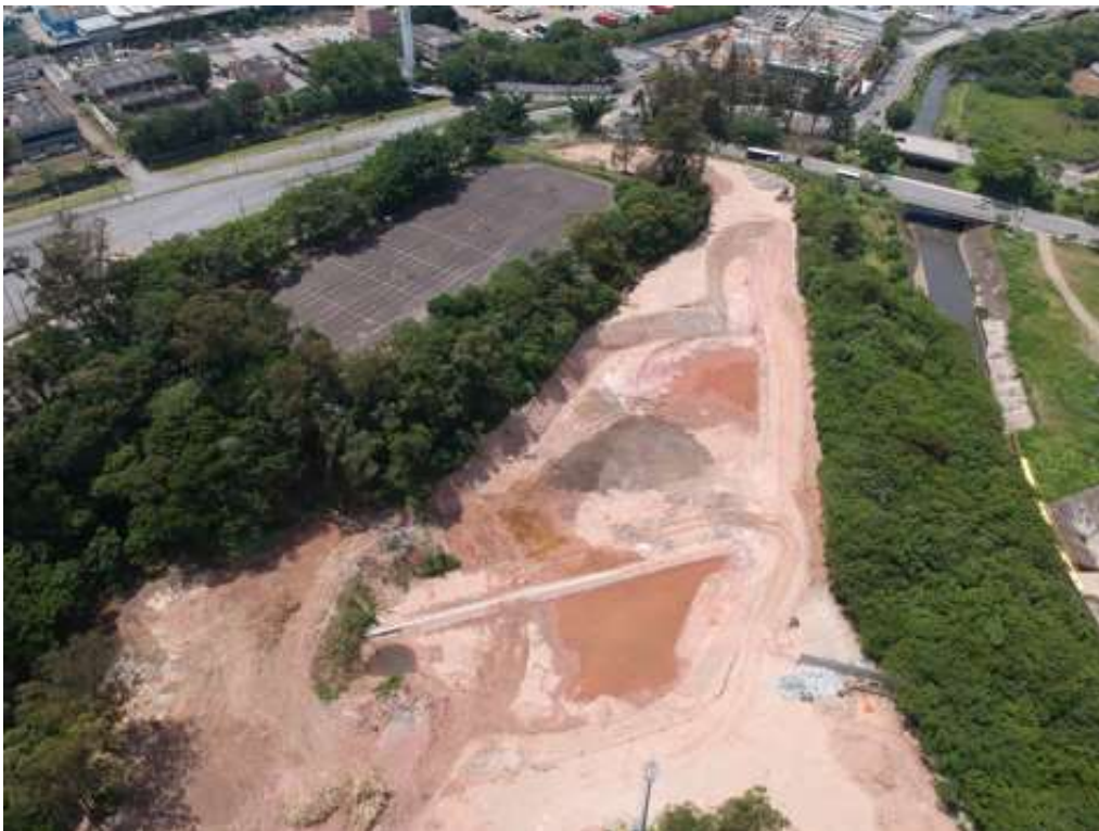
Pátio Vietnã, futuro prédio 1000 – 08/11/2021
