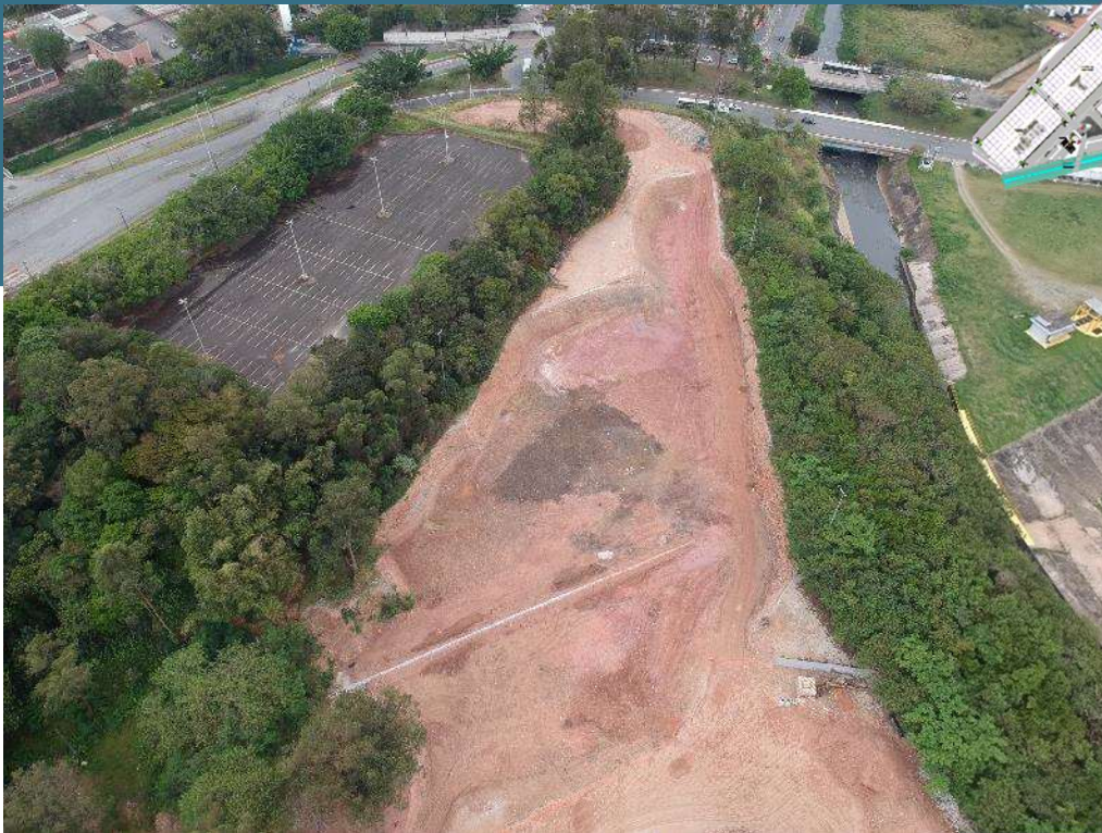
Pátio Vietnã, futuro prédio 1000 – 06/10/2021
