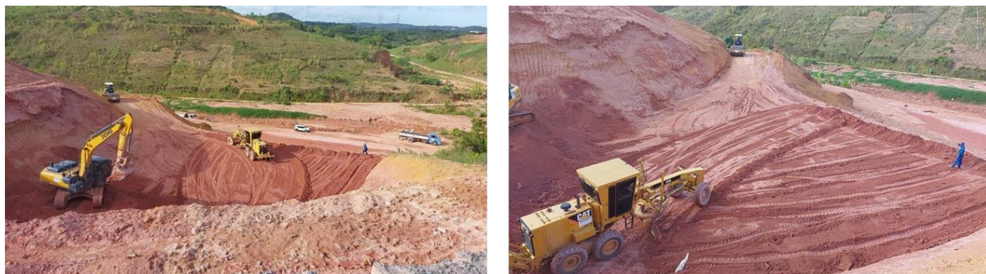
Imagem 9: Reparos no Talude
