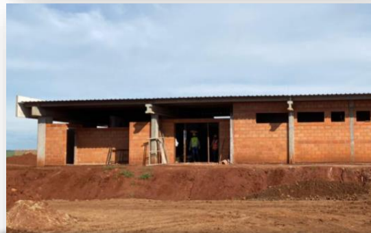
Escritório administrativo, laboratório e vestiário
