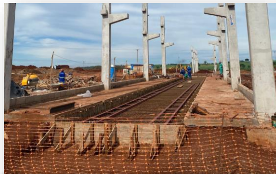
Tulha Ferroviária - Superestrutura
