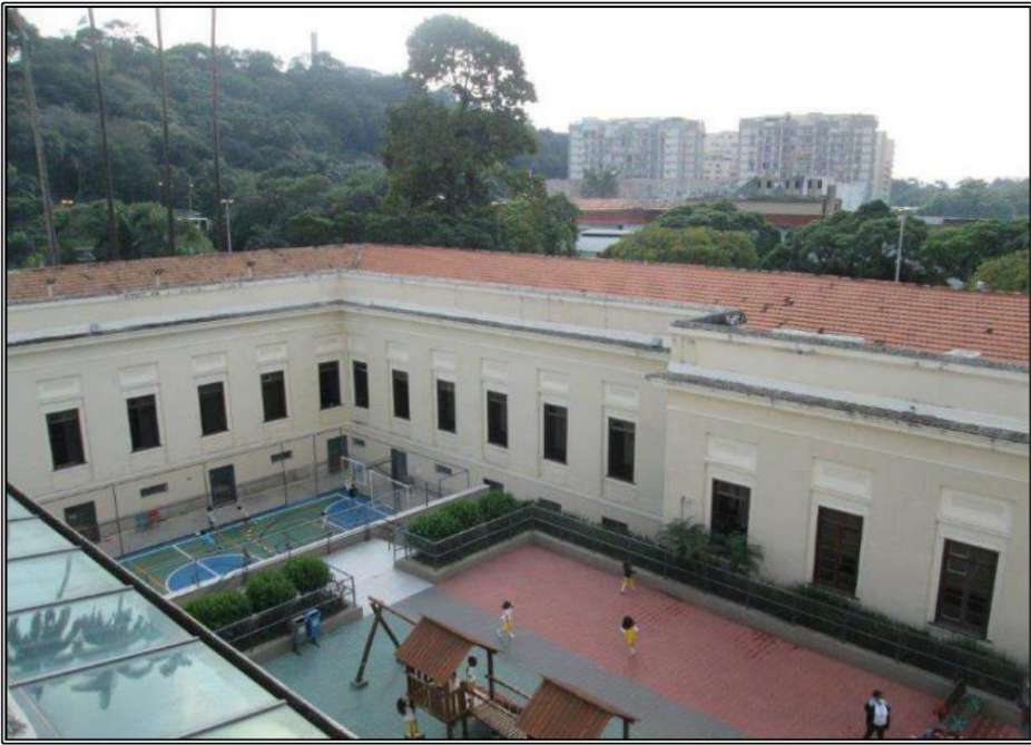
Vista do Pátio Interno
