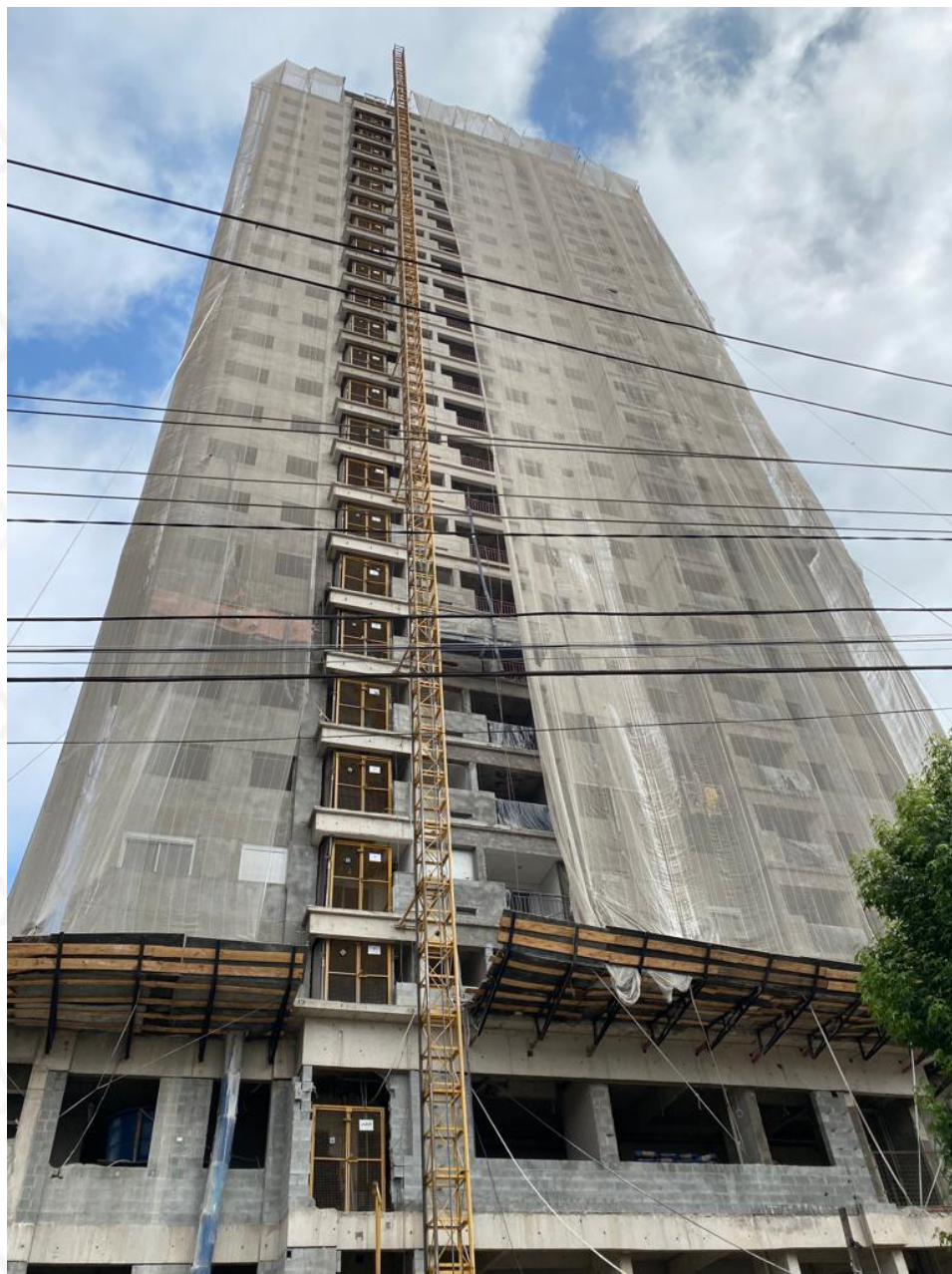
Estágio atual de obra (56,77%)
