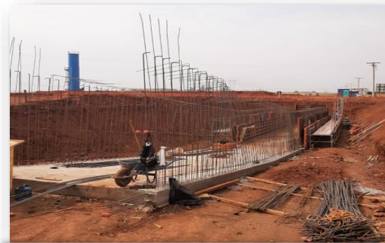
Armação do túnel da moega de descarregamento
