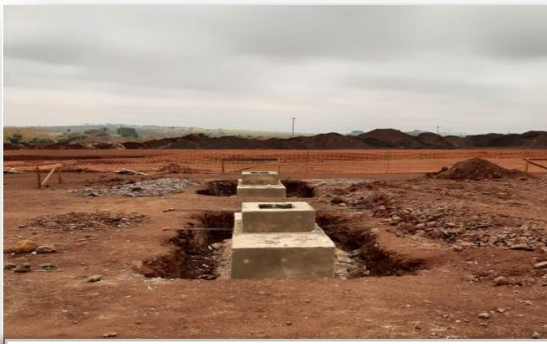
Infraestrutura Tulha Ferroviária
