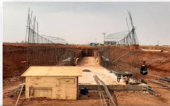
Armação do túnel da moega de descarregamento
