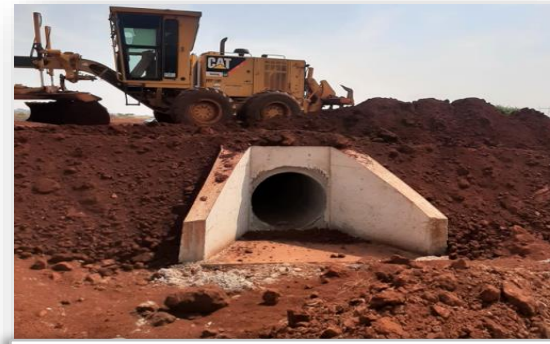
Finalização de Pontos de Drenagem
