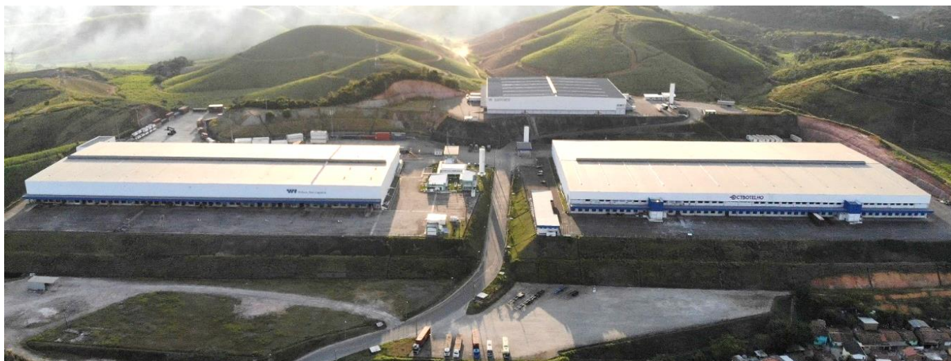
Imagem 3: Foto Aérea do Imóvel
