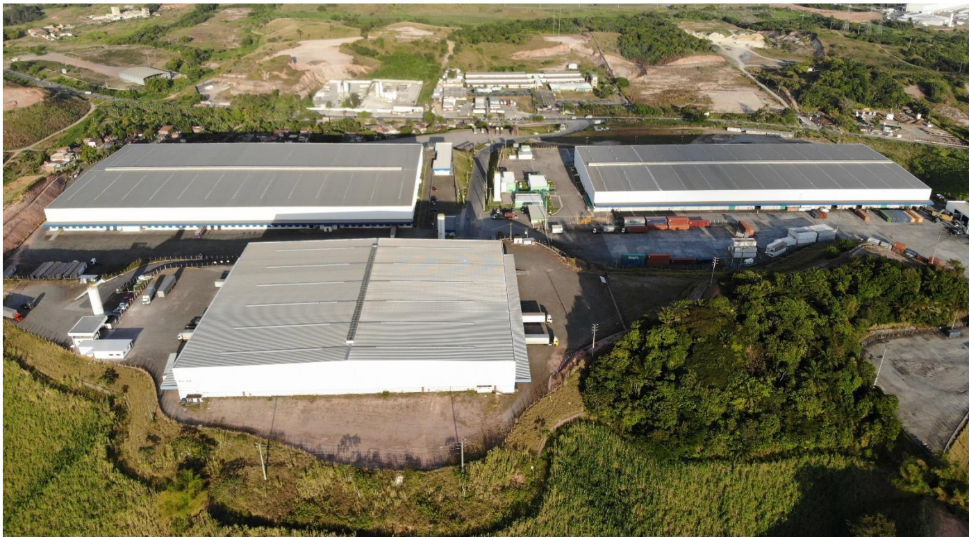
Imagem 5: Foto Aérea dos Galpões
