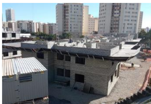
Foto Estrutura Obra
