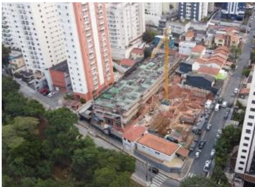
Foto Vista Geral Obra e início da Fundação
