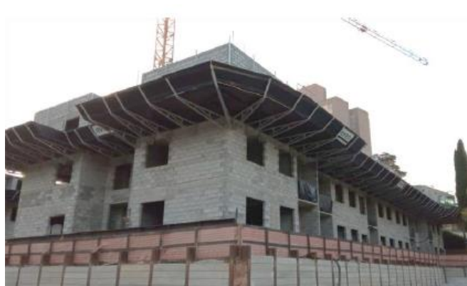
Foto Estrutura Obra
