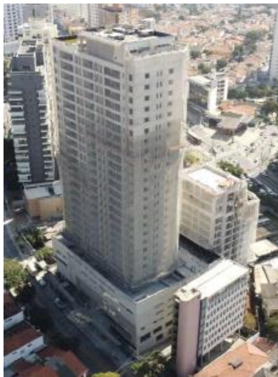
Foto Estrutura da Obra - Misce
