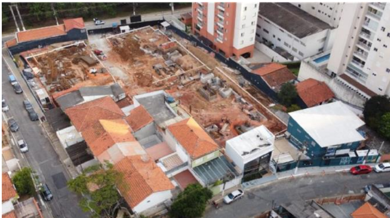
Foto Vista Geral Obra e início da Fundação
