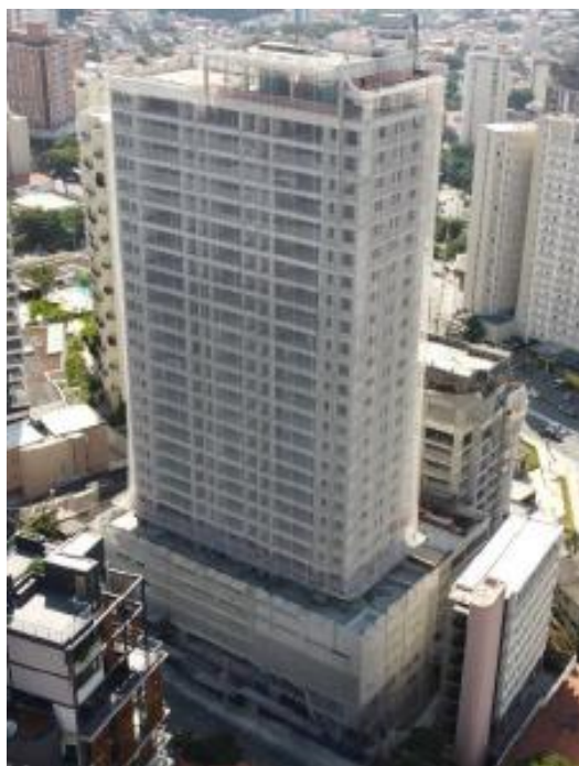
Foto Estrutura da Obra - Misce
