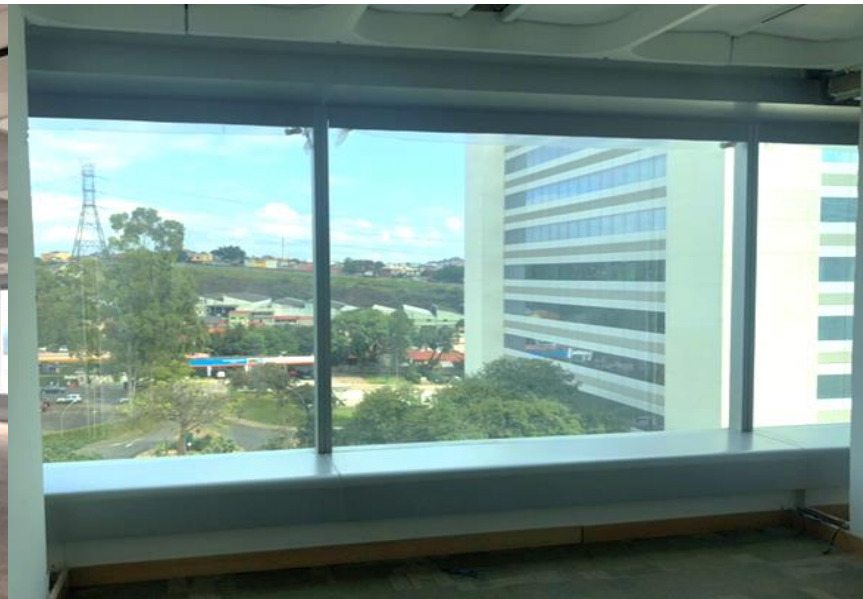
Vista Externa – Andar Tipo
