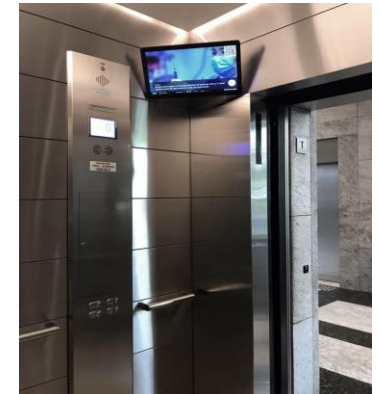
Modernização dos elevadores
