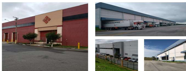
Barão de Mauá Atibaia / Jarinú, SP Rod Dom Pedro I, km 87,5, Ponte Alta Área Construída: 59.212 m 2 Participação: 100%
