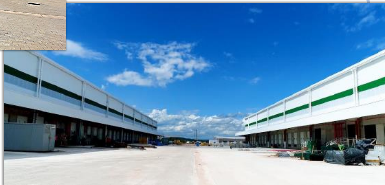
Área de carga e descarga
