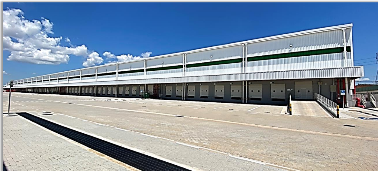
Vista lateral do galpão
