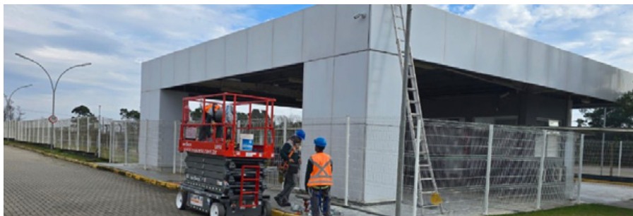
Portaria - Reforma de Cobertura - Renault
