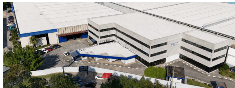
Área Externa do Galpão - CD Cotia
