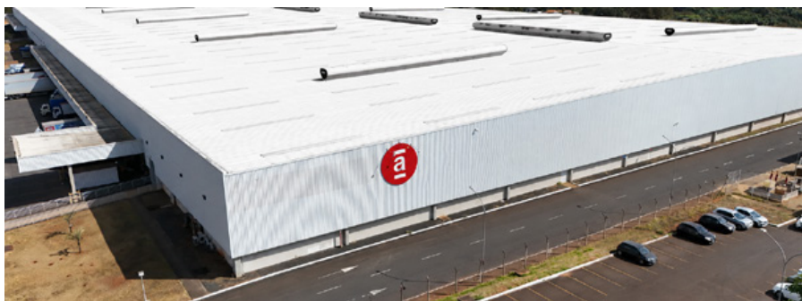
Área Externa do Galpão - Americanas
