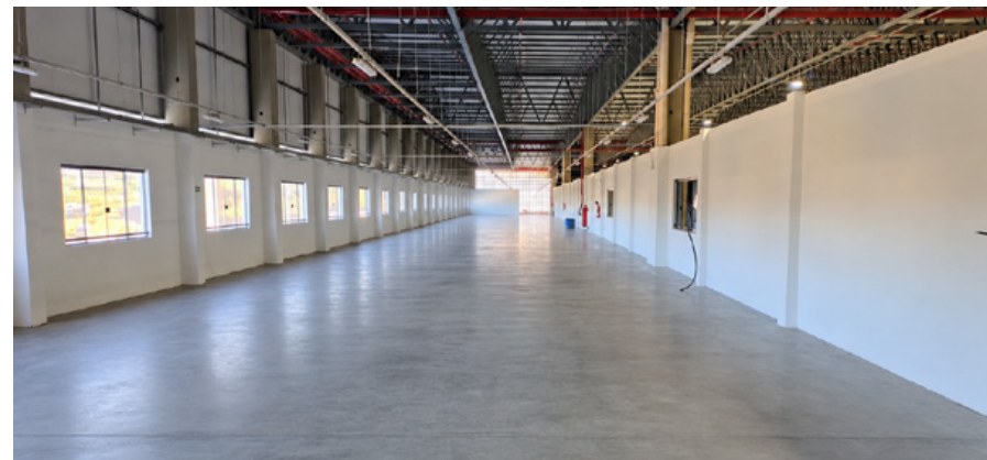
Mezanino do Galpão
