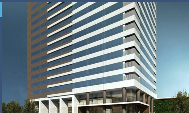
EDIFÍCIO COMERCIAL - GDE SP
