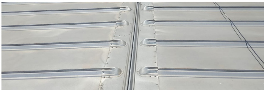
Cobertura do Galpão - Renault
