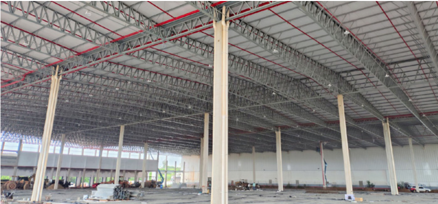
Cobertura do Galpão
