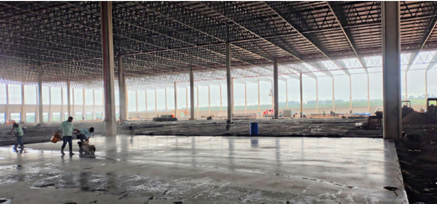
Concretagem do Piso
