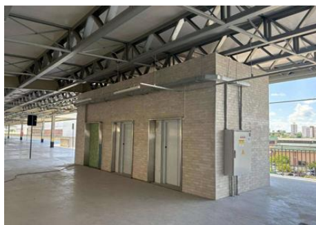
Obra retrofit Deck Parking: Finalizada a adequação do poço do elevador de acesso ao Mall. Fonte: HSI
