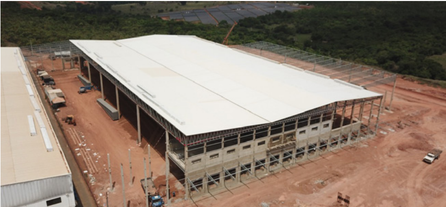
Vista aérea do Galpão
