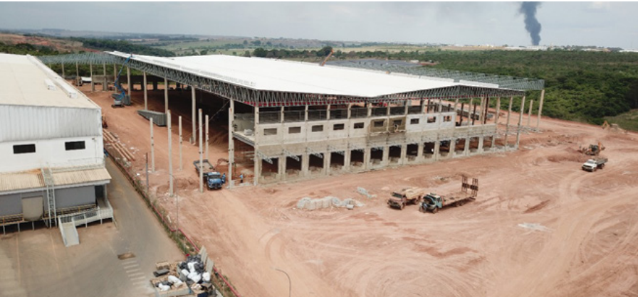
Vista frontal do Galpão
