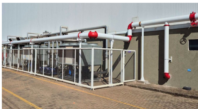
Interligação dos reservatórios com a nova tubulação às bombas existentes e pressurização da rede e entrega da nova bomba.
